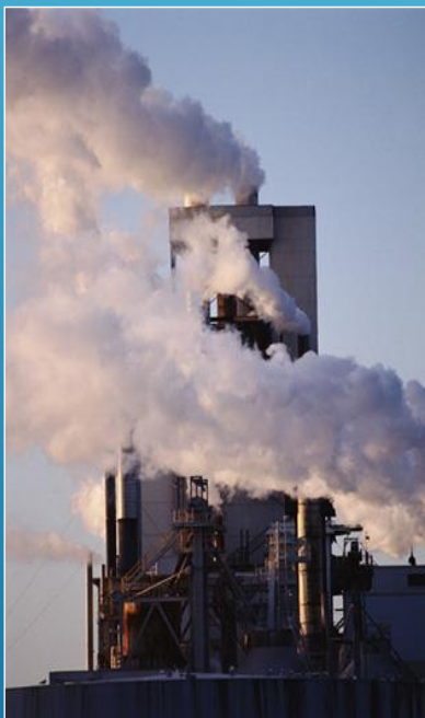
Tratamiento de gases de combustión
